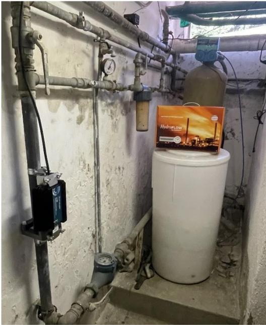
**Figura 2 - Vano tecnico del condominio con a sinistra il sistema HydroFLOW P45 e sullo sfondo il vecchio addolcitore che verrà smaltito a tutto vantaggio di spazio e pulizia**
