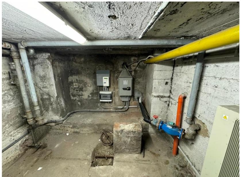
Fig.2: il locale tecnico sotterraneo, con arrivo acqua potabile dall'acquedotto
