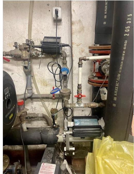
Figura 3: HydroFLOW P60 - Acqua calda sanitaria
