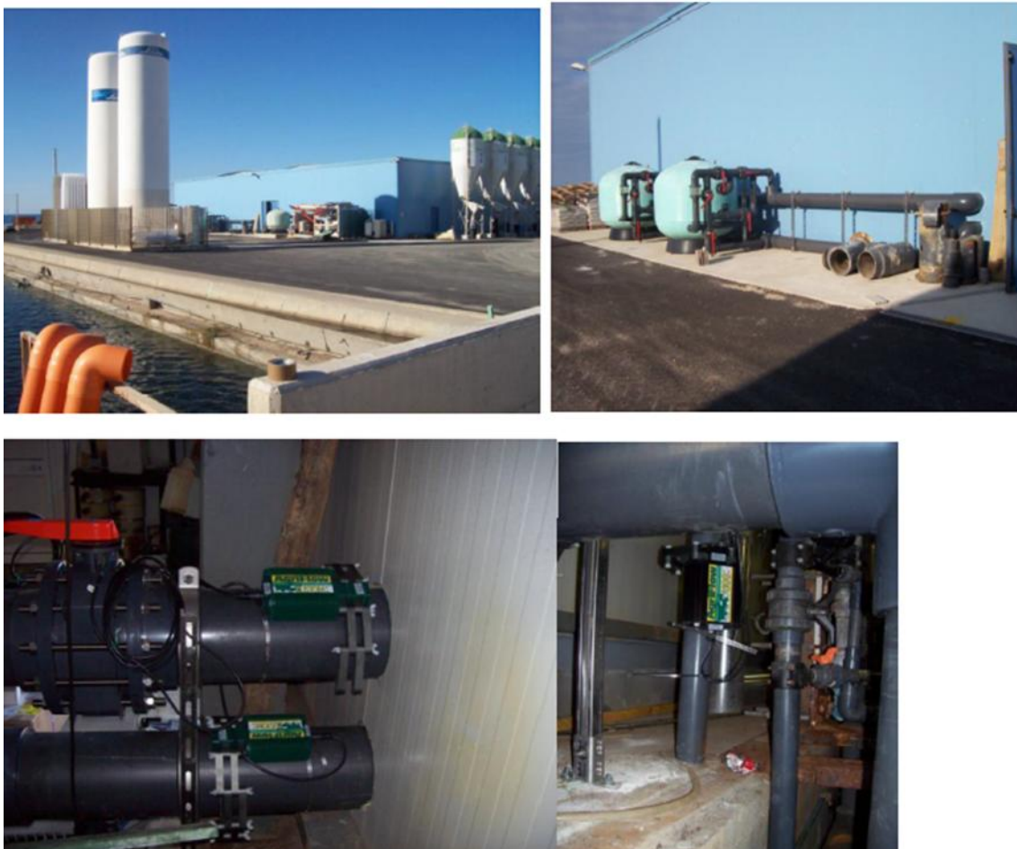
Fig. 3: Unità HYDROPATH Agriflow (riconducibile alla SERIE I HYDROFLOW attuale) installate
